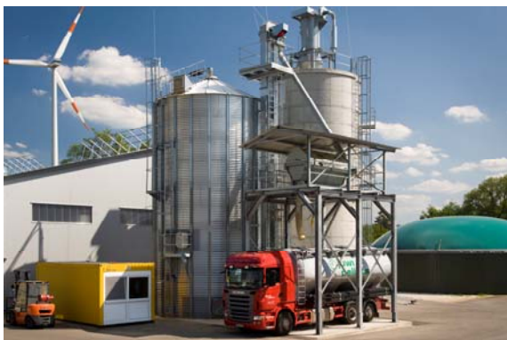
Centrale biomasse de Morbach - Allemagne - 0,5 MW électrique.
