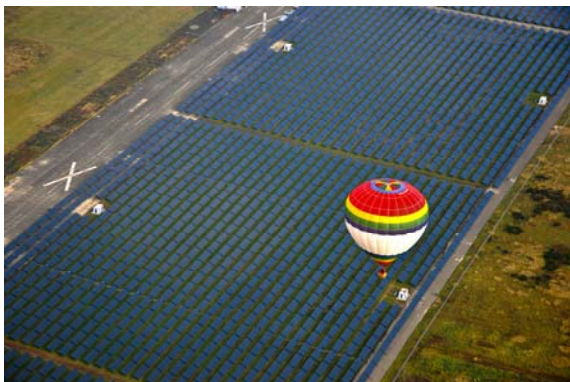
Parc photovoltaïque de Brandis - Allemagne - 40 MWc. Réhabilitation d'un ancien aéroport militaire.
