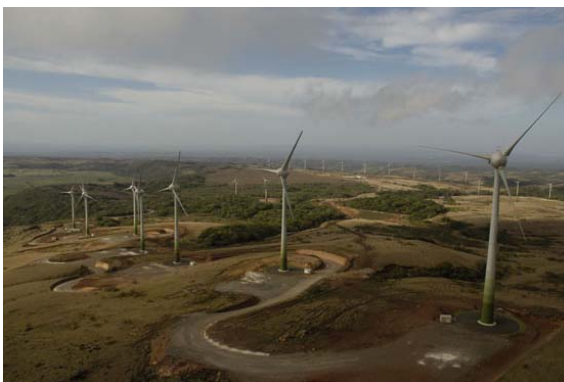
Parc éolien de Guanacaste - Costa Rica - 49,5 MW.
