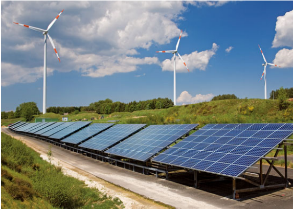
Plateforme éco-énergétique de Morbach - Allemagne.
