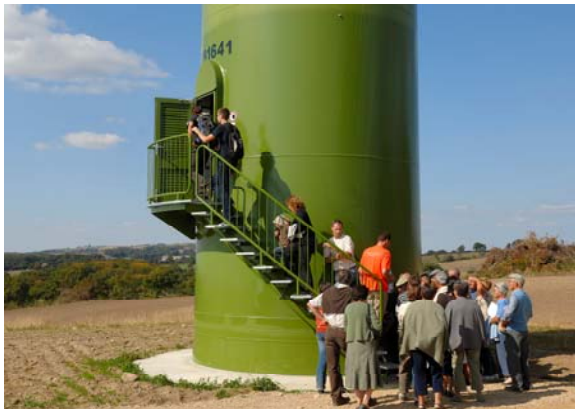
Visite d'une éolienne à Lestrade-et-Thouels - Aveyron.
