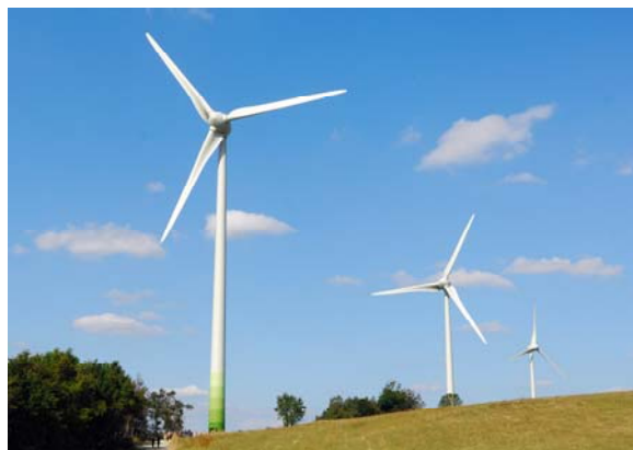
Parc éolien de Lestrade-et-Thouels - Aveyron.
