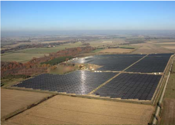
Parc solaire de Sabaranis - Ariège.
