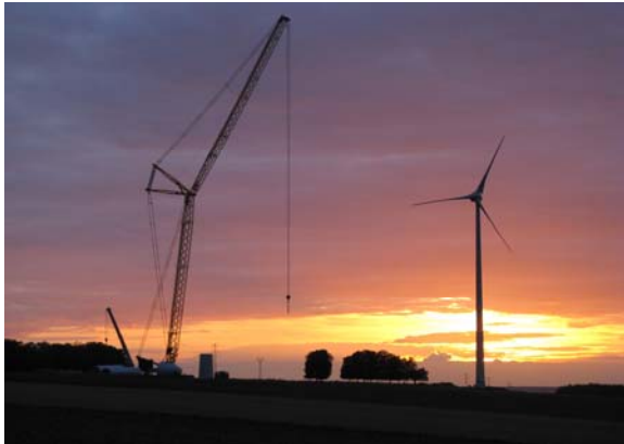
Grue de montage à Vaux-lès-Mouzon - Ardennes.
