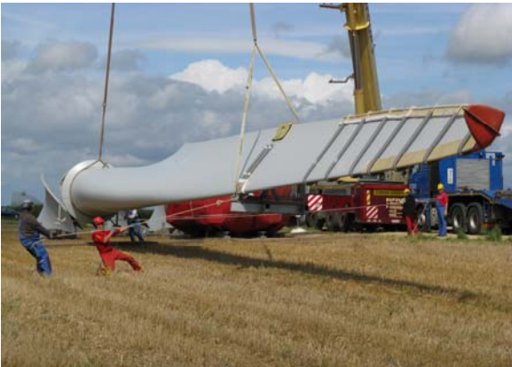
Montage d'une pale à Vaux-lès-Mouzon - Ardennes.
