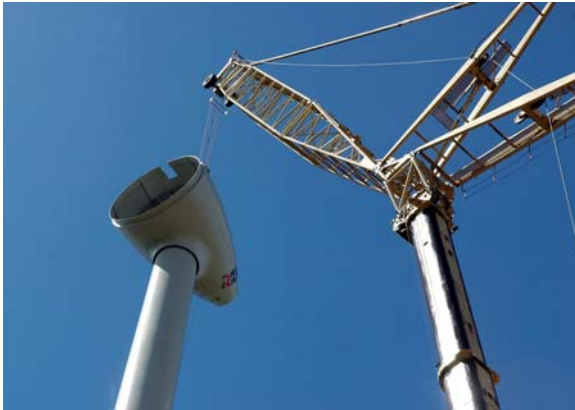
Montage du rotor à Plouguin-Kerherhal - Finistère.
