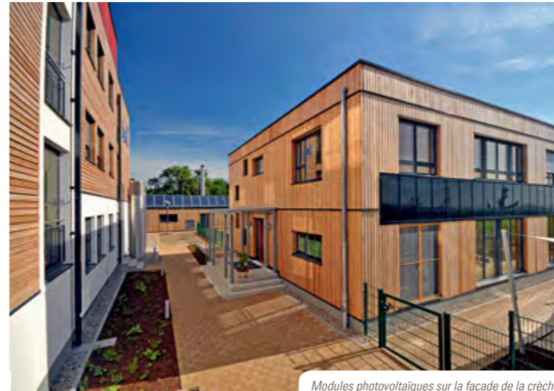
Modules photovoltaïques sur la façade de la crèche
