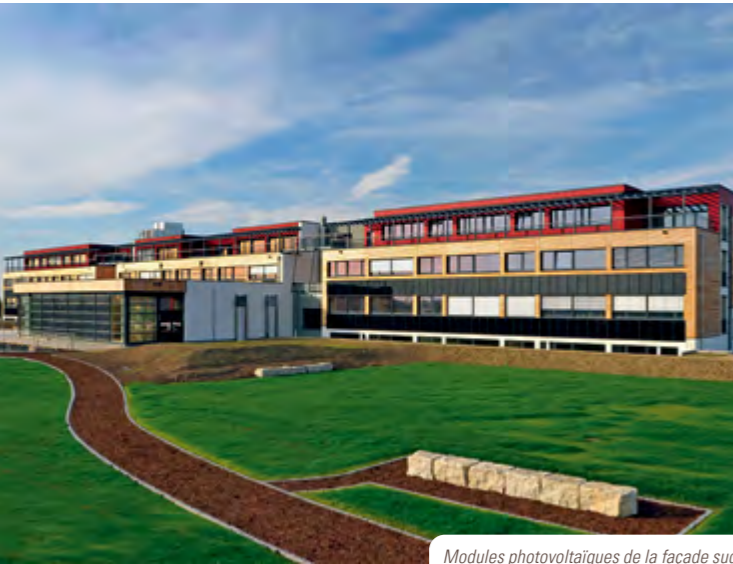
Modules photovoltaïques de la façade sud
