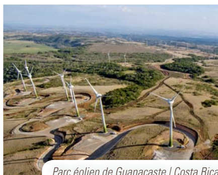
Parc éolien de Guanacaste | Costa Rica
