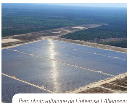
Parc photovoltaïque de Lieberose | Allemagne
